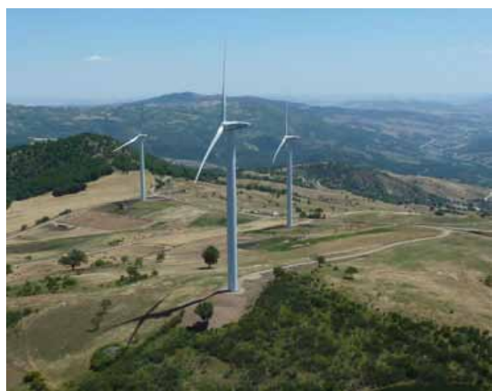
Parc éolien de Campomaggiore (Italie)
