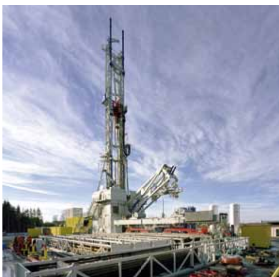
Forage Double à Kirchstockach (Allemagne)
