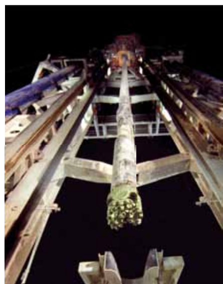
Double forage, Kirchstockach (Allemagne)
