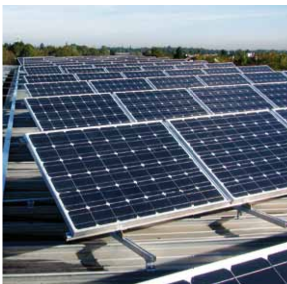
Installation sur toit, Bergsionschule (Allemagne)
