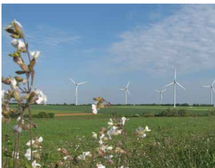
Parc éolien La Benâte (France)
