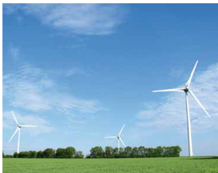
Parc éolien La Benâte (France)
