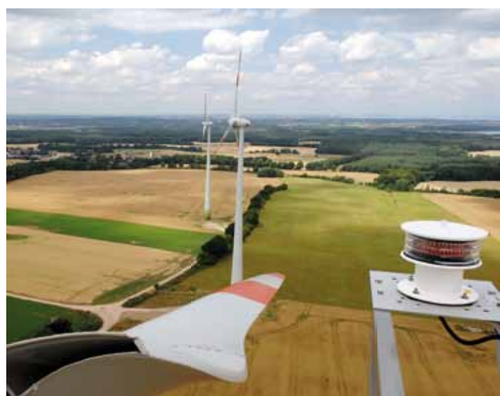
Parc éolien de Selmsdorf (Allemagne) - Feu de balisage
