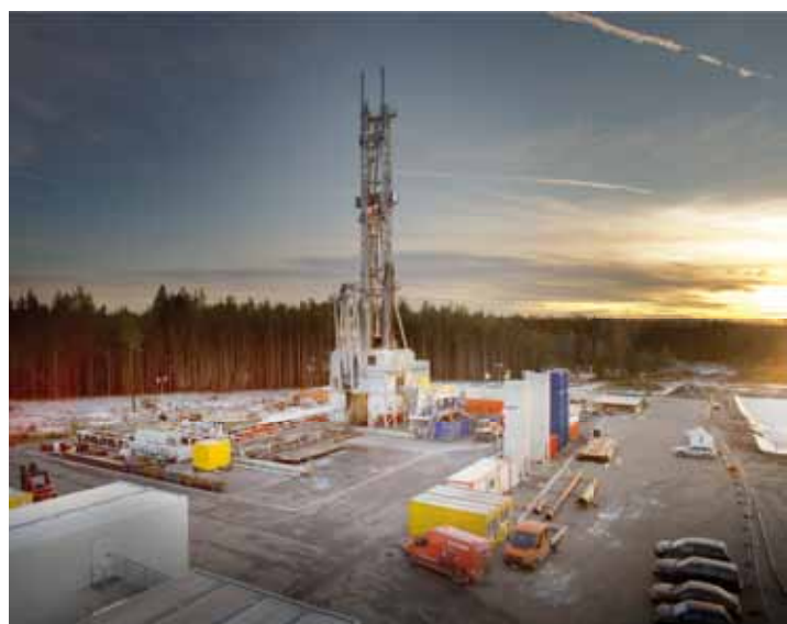
Forage Double à Kirchstockach (Allemagne)
