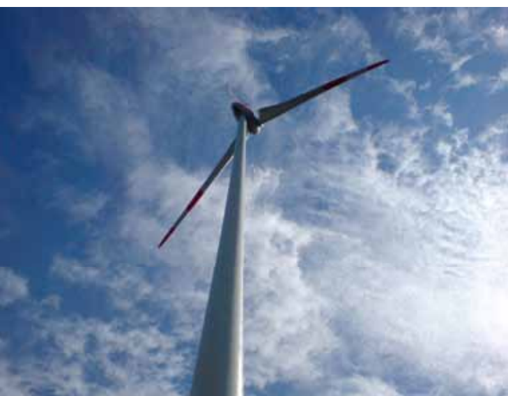
Parc éolien Namborn (Allemagne)
